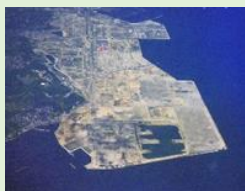
金沢地先埋め立て状況 (昭和53年)
